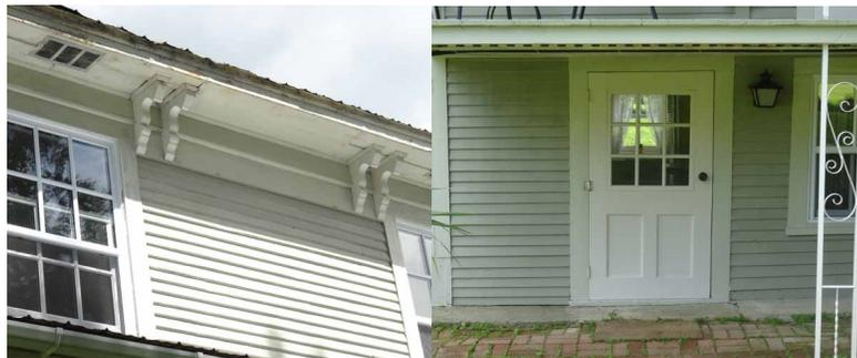
Maison cubique construite vers 1845, cette demeure du 715, chemin Craig présente un plan au sol de forme rectangulaire et les élévations du bâtiment de deux étages sont recouvertes de planches à clin. Sa fondation d'origine de pierre des champs est toujours présente. Du côté
