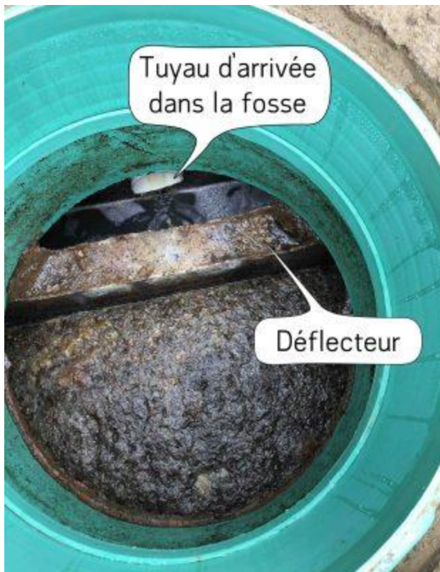
Figure 37 : Le tuyau d'arrivée dans la fosse a été dégagé des matières qui s'y accumulaient, l'eau y coule normalement.
